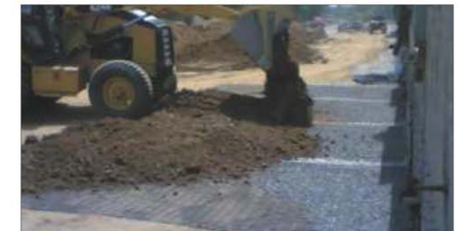
Step 8 : Backfill placement
